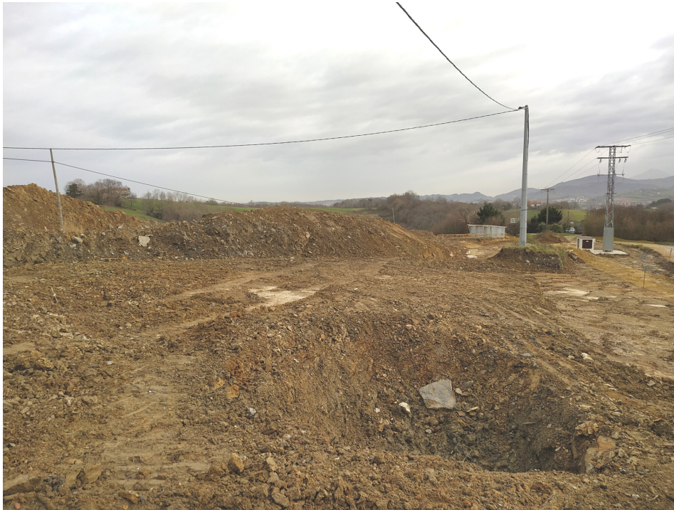
Zona de Zaldunborda en obras (Asier Polo)
