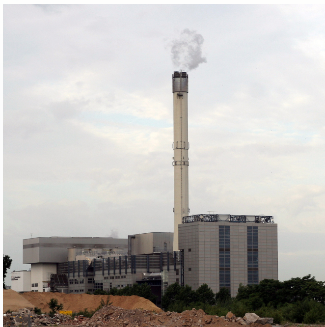
Incineradora (Armin Kübelbeck)
